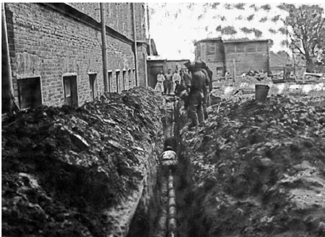
Прокладка одного из первых водопроводов в Смоленске
