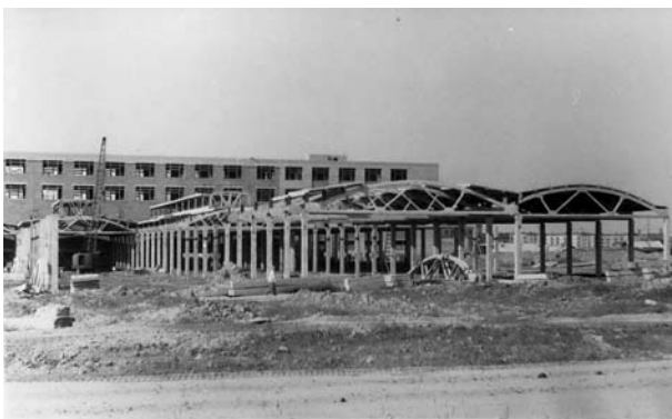
Строительство корпусов нового завода. Вторая половина 1960-х гг.
