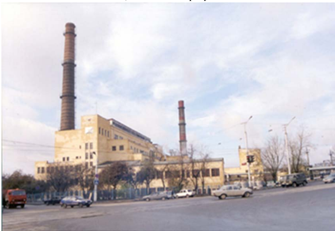
Рисунок 1.10 – Общий вид котельного цеха ПП «Смоленская ТЭЦ-2»
