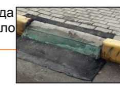
устройство съезда для колясок около подъезда
