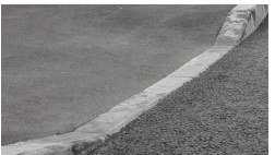
устройство съезда для колясок около подъезда
