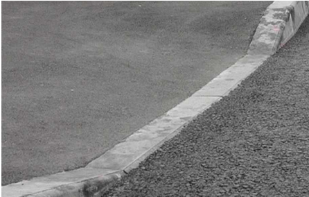
устройство съезда для колясок около подъезда
