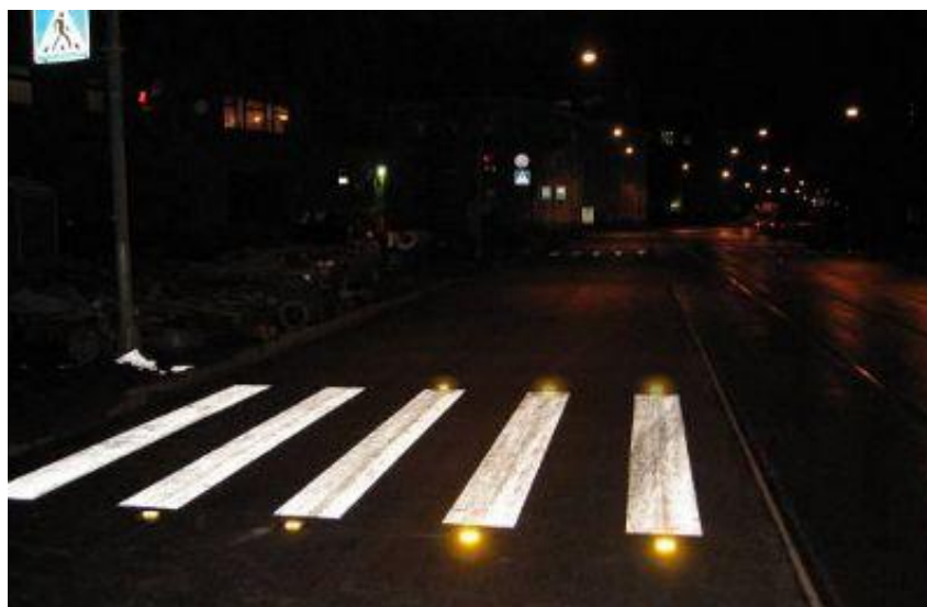
Рисунок 2.5.4 – Пример совместного использования дорожной разметки и световозвращателей
